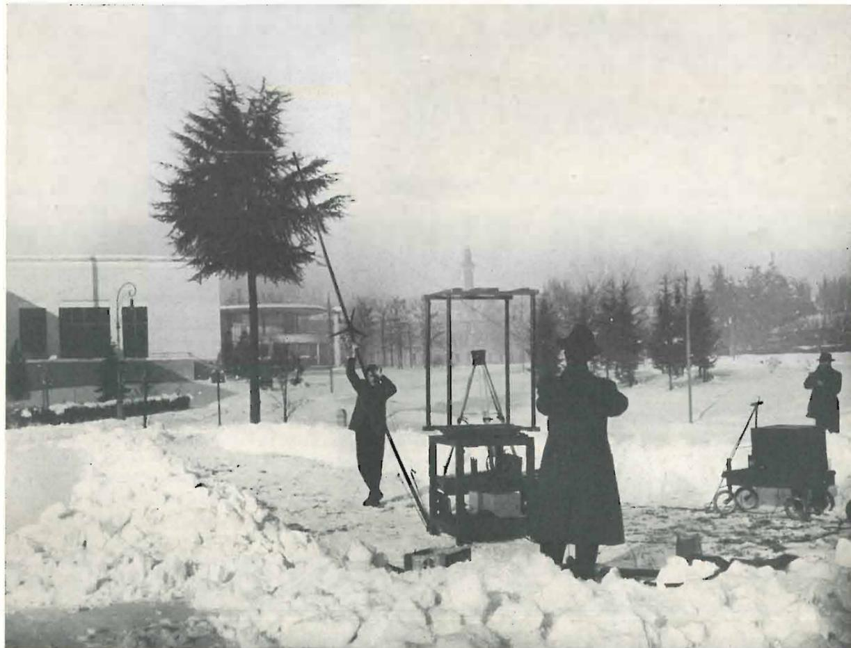
Fig. 1. — Apparecchiatura campale per il rilievo delle irradiazioni parassite prodotte dai televisori (e dai ricevitori fonici M.F.), in corso d'installazione.
